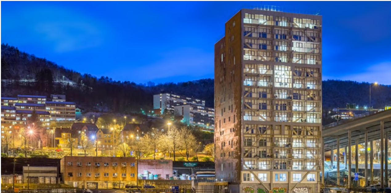
Treet (Bergen, Nórsko) – 14-podlažná rezidenčná budova s výškou 52,8 m
